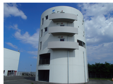
津波避難施設
