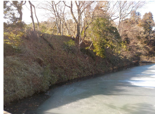
イ 植生修景後の土塁（五色沼側）
