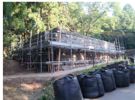
図 7-8 中門石垣修復時の様子
