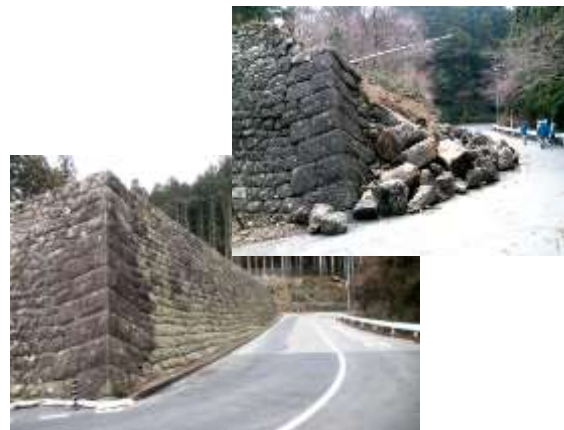
図 2-23 東日本大震災による本丸北西石垣の 被災と修復状況
