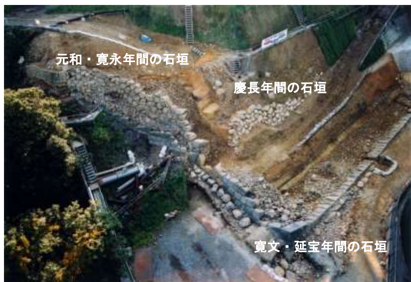
図 2-16 本丸北壁石垣北東部で確認された石垣の変遷
