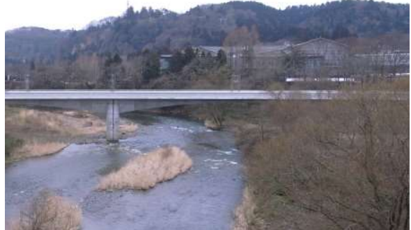
図 5-13 中の瀬橋からの遠景 (平成 27 年 3 月撮影)
