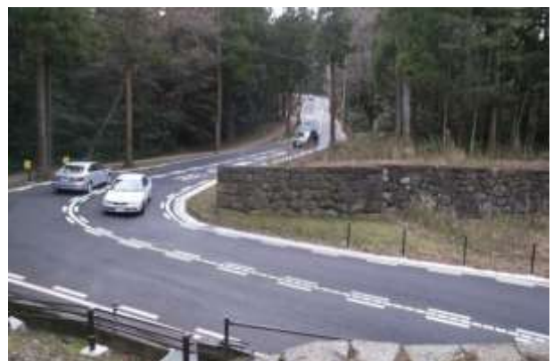
図 5-5 中門石垣に近接する市道
