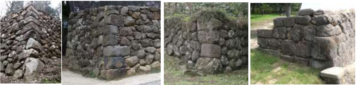
図 3-89 野面石・割石による隅角部 (左から) 清水門・酉門・中門南・大手門北
