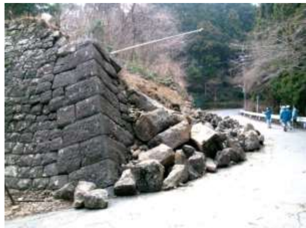
図 3-99 平成 23 年（2011）東日本大震災による 本丸北西石垣の被災状況
