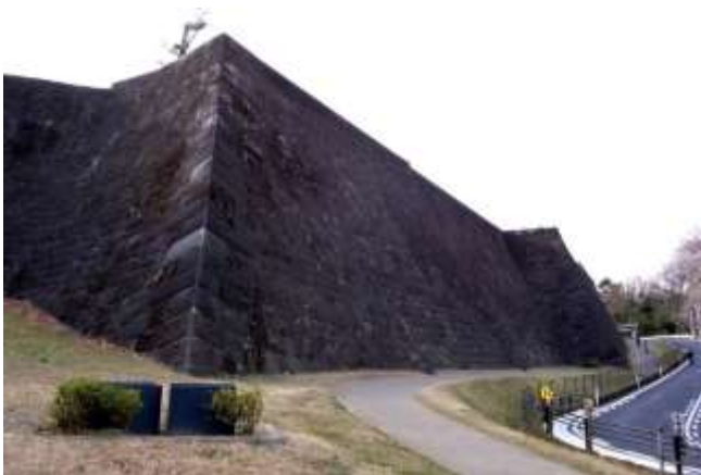
図 3-90 寛文地震の修復石垣 本丸北壁石垣
