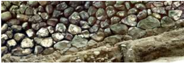
図 3-87 清水門石垣基部
