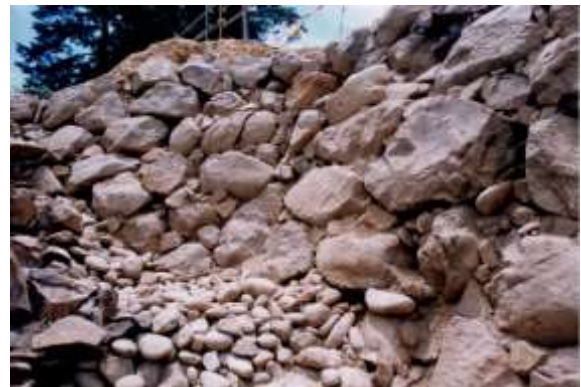
図 3-84 元和地震の修復石垣（細部） 57～68度の勾配
