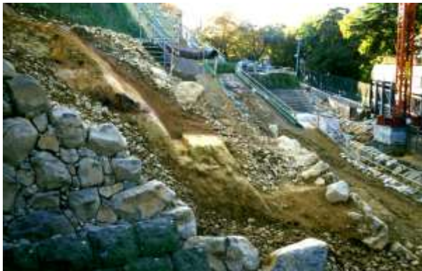
図 3-81 本丸北東部の築城期石垣 途中に小段を有する
