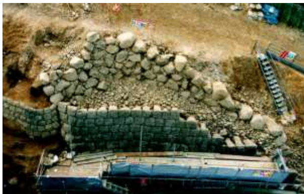
図 3-83 元和地震の修復石垣 前面に寛文地震の修復石垣を築く
