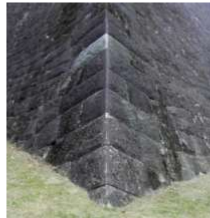
図 3-91 寛文地震の修復石垣(本丸北壁石垣) 隅角部の算木積み
