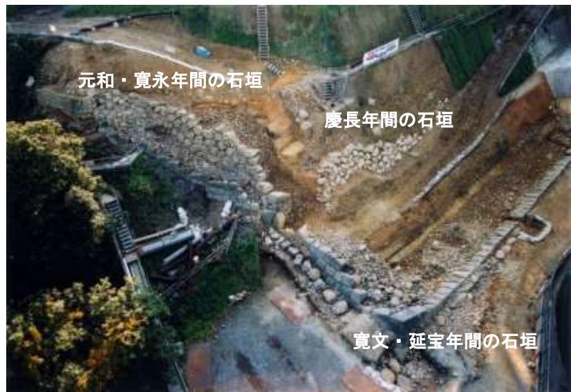
図 2-16 本丸北壁石垣北東部で確認された石垣の変遷
