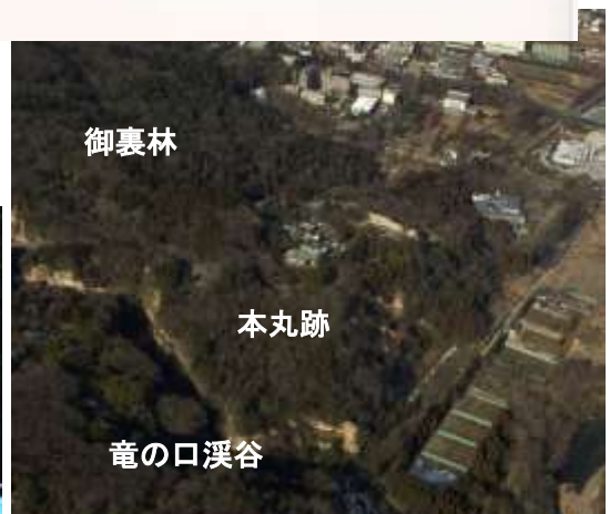
図 2-11 本丸跡から御裏林にかけての自然 景観 (南東から撮影)
