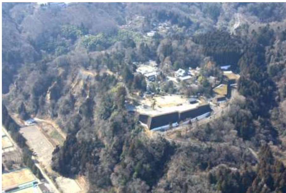
図 2-26 仙台城本丸跡空撮（北東から）
