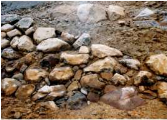
図 3-79 本丸北東部の築城期石垣（細部）
