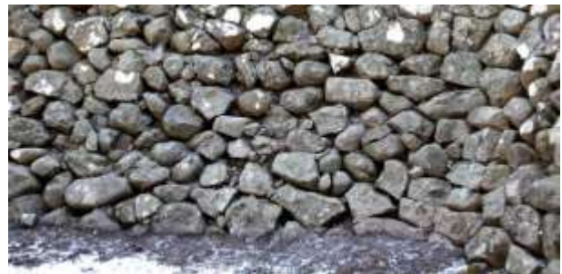
図 3-86 本丸北西石垣基部
