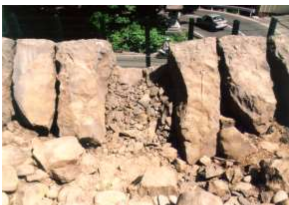
図 3-92 寛文地震の修復石垣(本丸北壁石垣) 控えの長い築石
