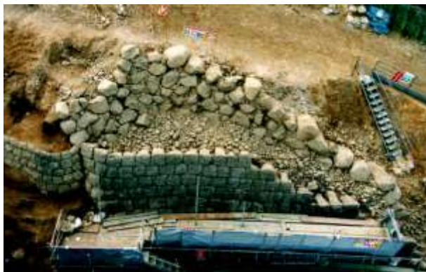
図 3-83 元和地震の修復石垣 前面に寛文地震の修復石垣を築く
