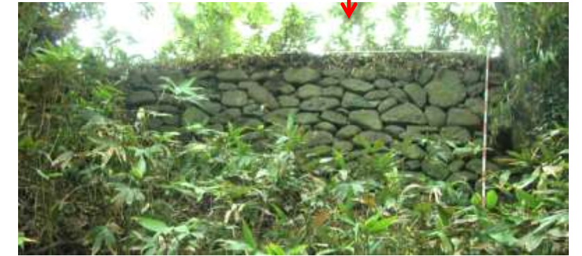
⑦筋違橋付近の石垣
