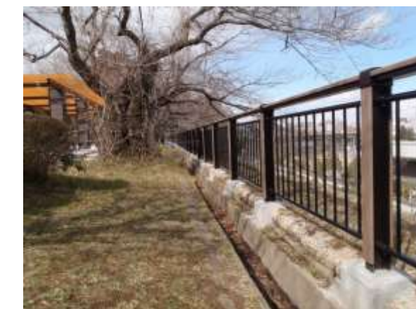
東側土手のフェンス・側溝
