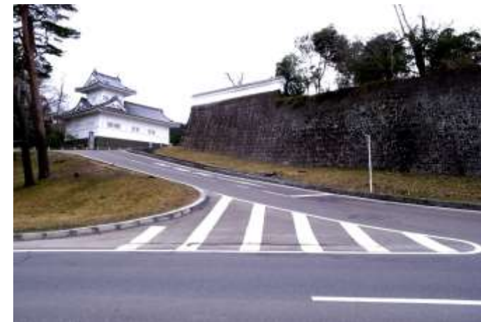
⑥-2 大手門跡付近 登城路と石垣 大手門脇櫓は昭和42年に市が寄贈を受ける
