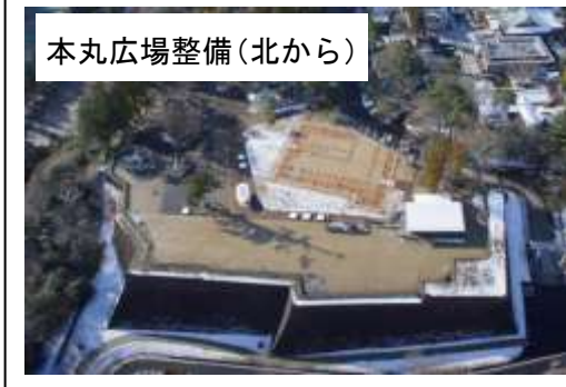
本丸広場整備（北から）
