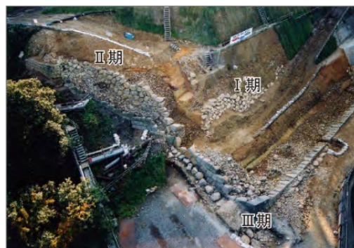
図 2-6 本丸北壁石垣で確認した3時期の石垣
