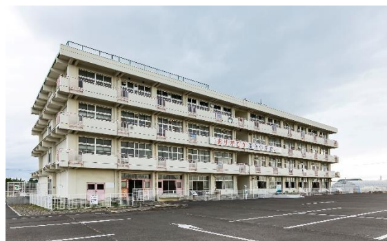
震災遺構仙台市立荒浜小学校
