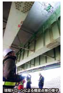
球殻ドローンによる橋梁点検の様子
