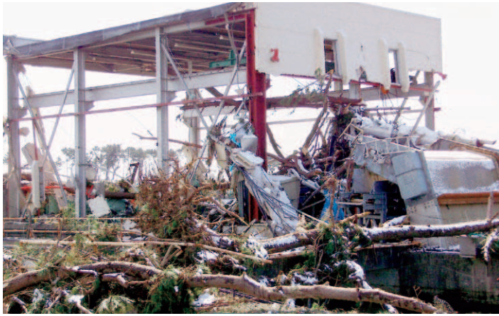
■平成23年3月18日 大堀排水機場
