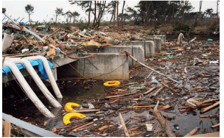
■平成23年3月21日 二郷堀排水機場
