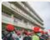
震災遺構 仙台市立荒浜小学校
