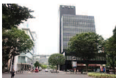
⑦ 一番町四丁目商店街から(入口) 民間オフィスビルで公園と分断
