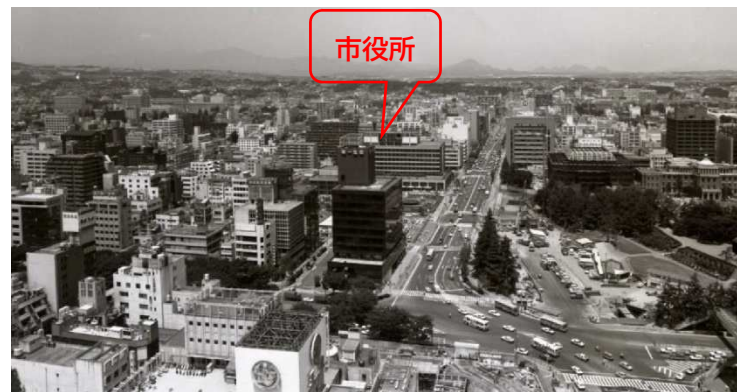
東二番丁通と勾当台通との直線化（クランク解消）工事（昭和 60 年頃）
