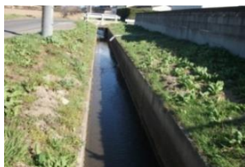
水路土砂浚渫後
