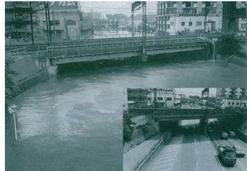
青葉区五橋～若林区新寺 都市計画道路 清水小路多賀城線：深さ 4m 以上浸水し、 道路寸断
