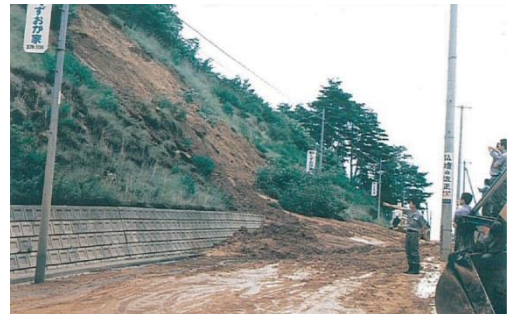
青葉区葛岡墓園付近：崖崩れにより道路寸断
