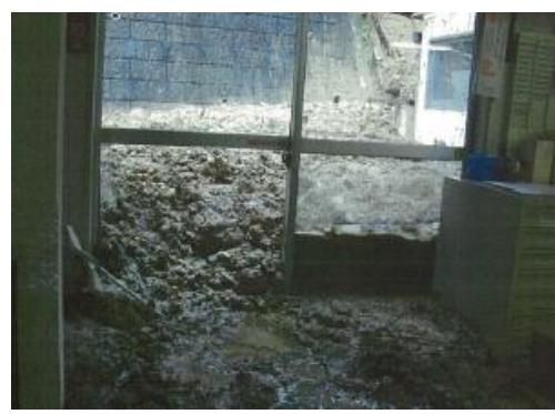
宮城野区岩切入山：斜面崩壊土砂の企業事務所への流入
