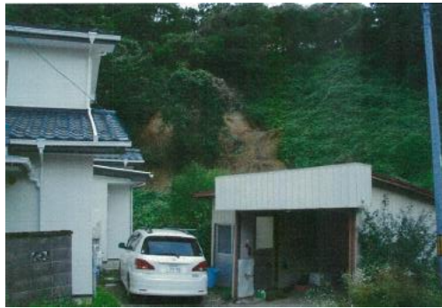
太白区三神峯：人家裏の斜面崩壊
