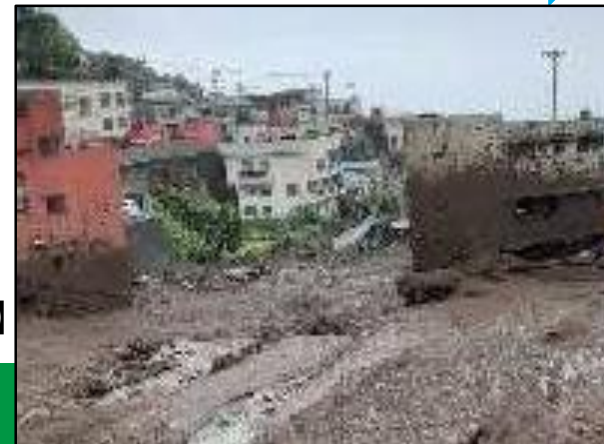
令和3年7月 静岡県熱海市で 発生した土石流 【出典:国土交通省】
