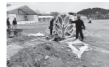
サイン等造形物の据え付け (R5.4)
