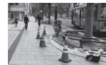
舗装上仮設花壇の枠製作 (R5.4)
