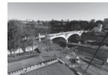
上空からの様子（車両に係留資材として利用）
