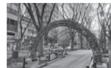
立体花壇の躯体搬入・設置 (R5.3)
