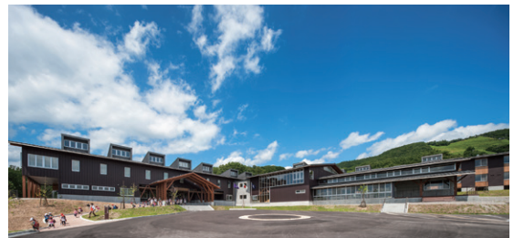
地域産材を活用した木造建築の事例(泉岳自然ふれあい館)
