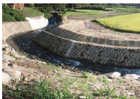
空積み護岸の整備による 河川周辺環境への配慮
