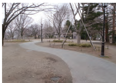
公園に整備された透水性舗装（西公園）
