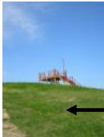
公園盛り土の例(仙台市冒険広場) 今次津波に対して避難施設として機能
