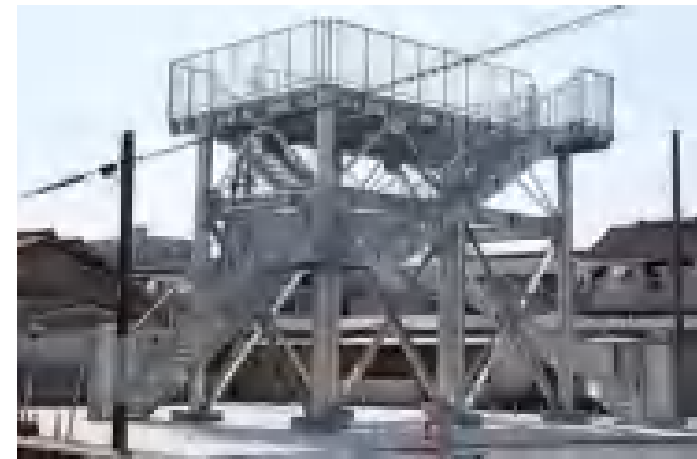
津波避難タワーの例(和歌山県田辺市)
