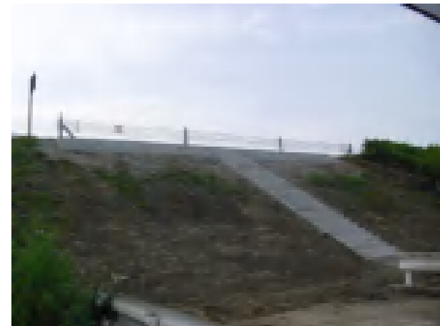
津波避難階段の例(仙台東部道路)
