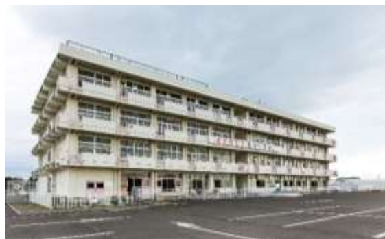
震災遺構仙台市立荒浜小学校
